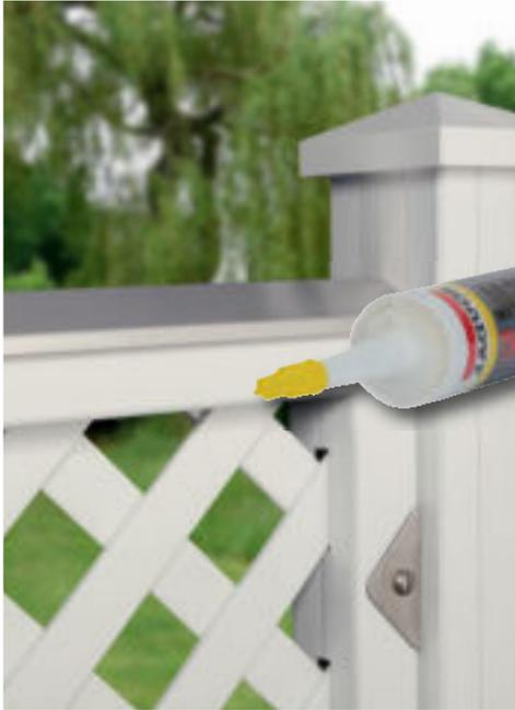
Designaufsatz Alu mit MS-Polymer-Kleber (1398) befestigen.
