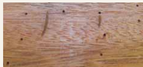
„Pinholes“ bei überseeischen Harthölzern
