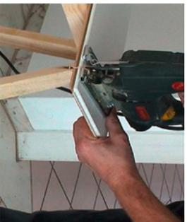
Im Vergleich zu Gipskarton sind Paneele langlebiger, robuster und pflegeleichter aufgrund ihrer Oberfläche, sowie schneller zu verlegen. Die Gesamtkosten sind vergleichsweise gering. Zudem ermöglichen Paneele aufgrund der Unterkonstruktion hervorragende Möglichkeiten zur Schall- und Wärmedämmung.
