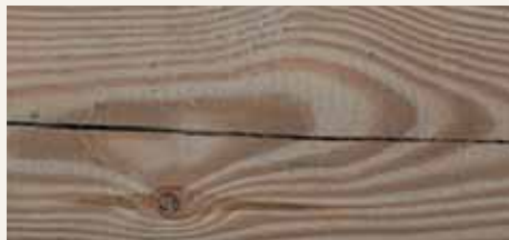
Spannungsrisse durch die Holz Trocknung
