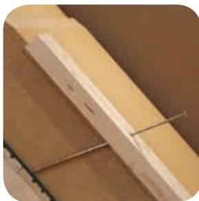
Auf der Sichtschalung wird eine Dampfbremse verlegt. Darauf kommt eine Lage GUTEX Thermosafe-homogen®. Mit der GUTEX Multiplex-top® wird eine regensichere Unterdeckung hergestellt.
